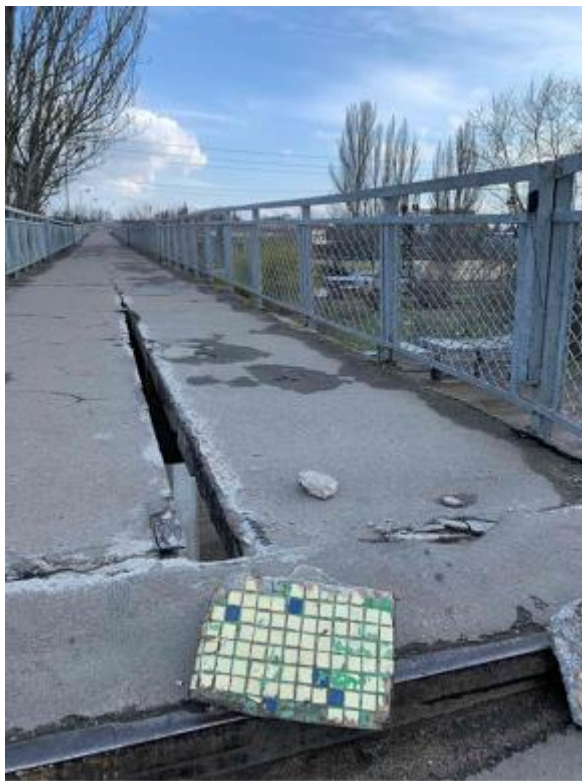
Рис.4. Порушення суцільності, переміщення в горизонтальному напрямку до 180 мм і вертикальному до 75-100мм балки крайнього прогону пішохідного мосту зі сторони мікрорайону Таврійський міста Херсон
