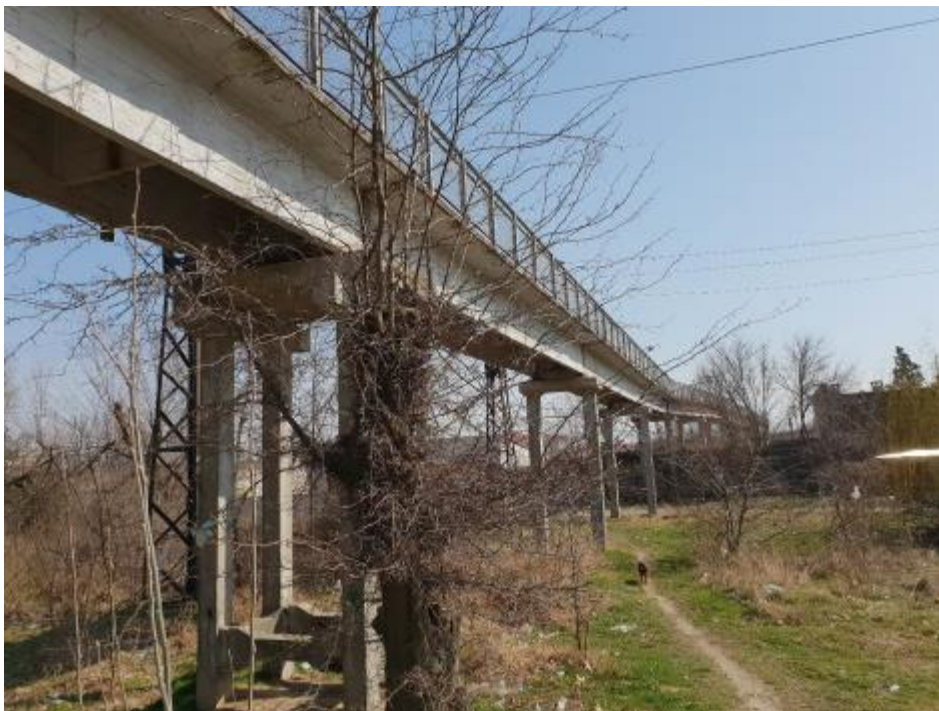
Рис.2. Загальний вигляд ділянки пішохідного моста з західної сторони в напрямку залізничного вокзалу міста Херсон
