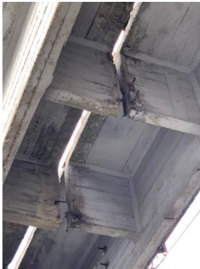
Рис.6. Вид знизу. Порушення з'єднання діафрагм і плитних частин залізобетонних балок прогону пішохідного мосту
