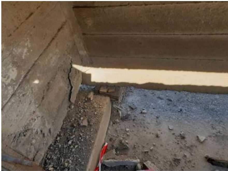
Рис.7. Не забезпечене проєктне обпирання балки зі східної сторони крайнього прогону пішохідного мосту. Сколювання, відшарування бетону діафрагми балки
