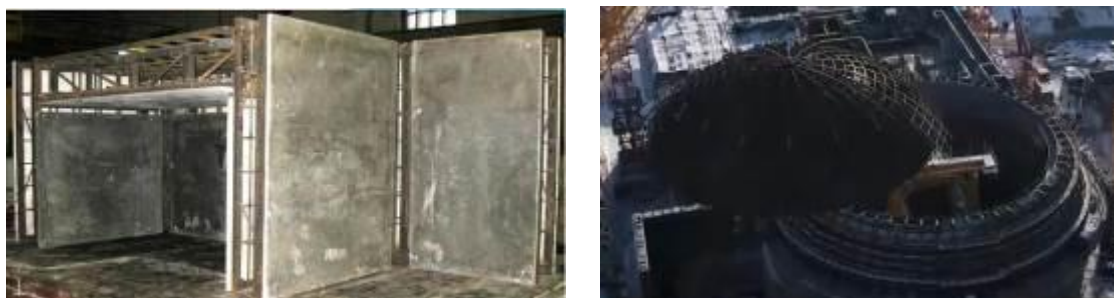
Рис 1. Термостойкая несъемная опалубка из сталефибробетонных панелей стен зданий и купола Курской АЭС -2.
