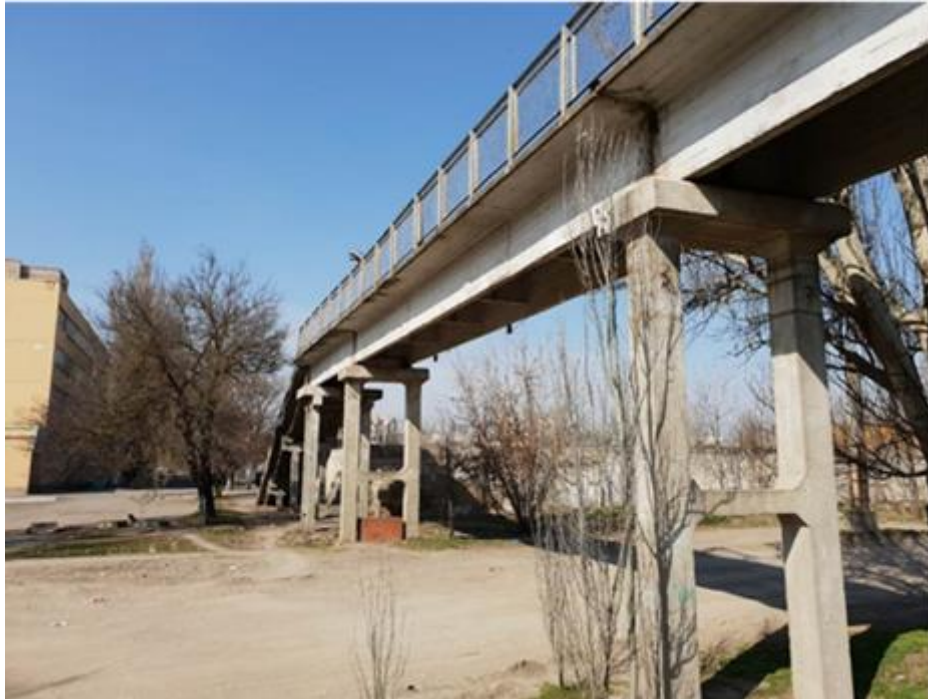
Рис.1. Загальний вигляд ділянки пішохідного моста із західної сторони в напрямку мікрорайону Таврійський міста Херсон
