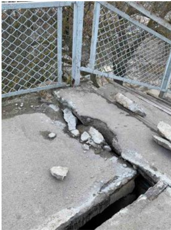
Рис.5. Порушення асфальтового покриття, з'єднання, переміщення крайньої балки з західної сторони по вертикалі до 75-100 мм і по горизонталі до 180 мм
