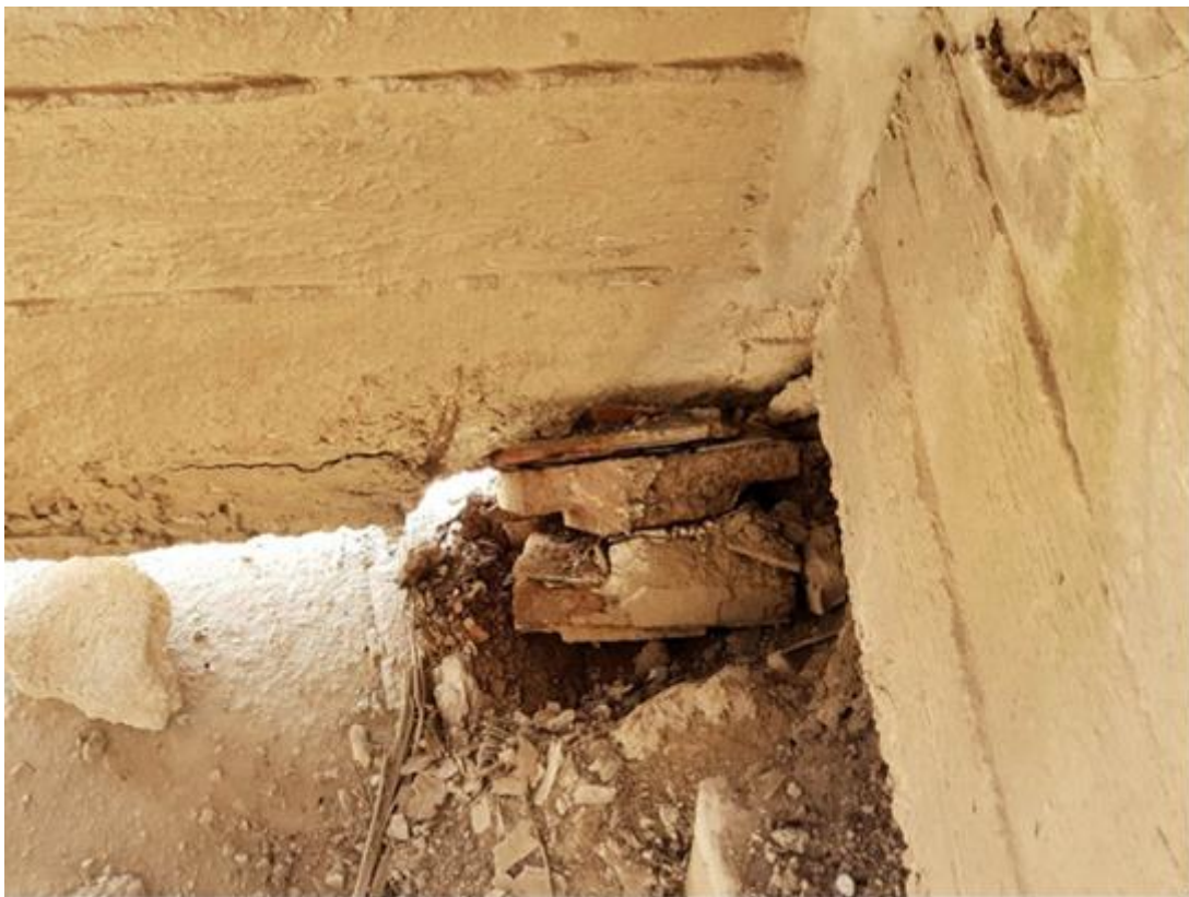
Рис.7. Зсув балки, розташованої із західної сторони прогону, нахил опорної частини, руйнування її опорної зони, підливки, зміщення балансирів опорної частини, місцеве руйнування бетону, корозія опорної частини і металевої пластини над нею, поздовжня тріщина у балці. Стан вузла обпирання - непрацездатний
