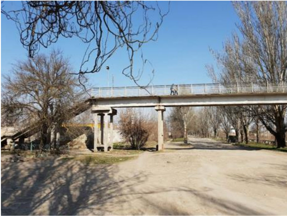
Рис.3. Загальний вигляд крайнього прогону пішохідного моста, що обстежується
